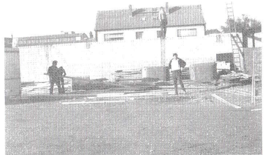
Foto oben : Baustelle des Schützenhauses der Bruderschaft 1965
